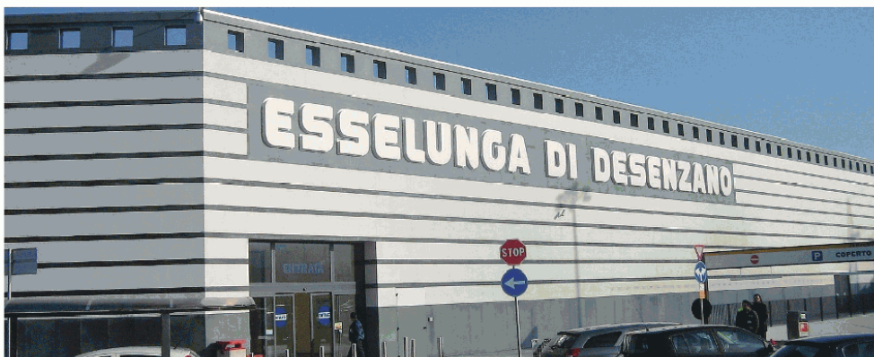
La nuova struttura commerciale Esselunga realizzata a Desenzano in tempi record
